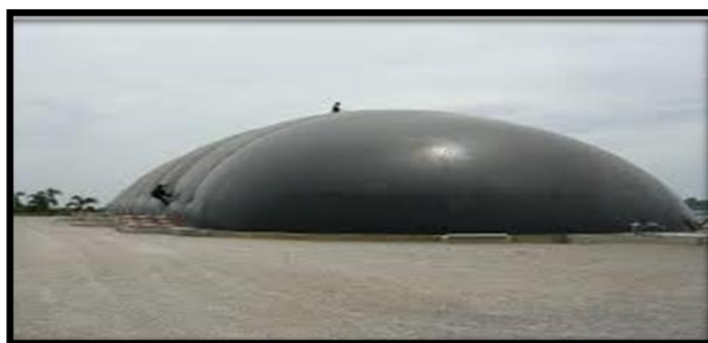
ภาพที่ 25 ระบบบ่อหมักย่อยประยุกต์เมื่อเกิดก๊าซชีวภาพปากบ่อจะขยายตัวขึ้น ที่มา: สำนักจัดการคุณภาพน้ำ กรมควบคุมมลพิษ (2558)
