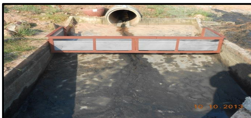
ภาพที่ 19 ตะแกรงสำหรับกรองเศษใบไม้ ทราย กรวด จากน้ำเสียที่ออกจากการผลิต ที่มา: การยางแห่งประเทศไทย อำเภอลำปาง จังหวัดอุดรธานี
