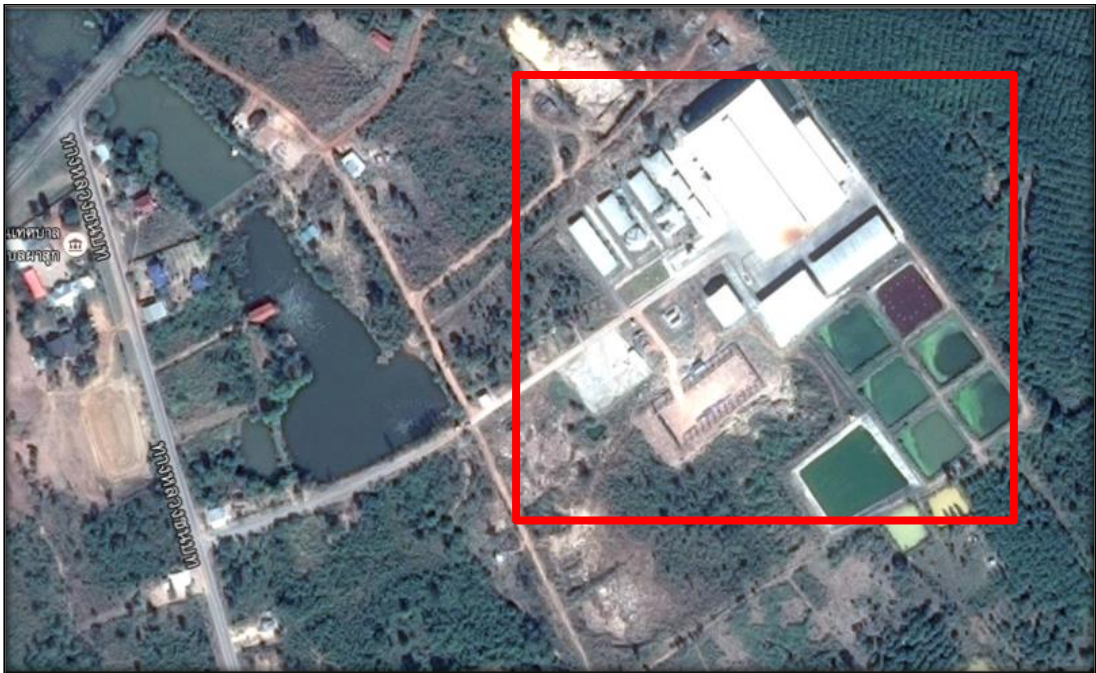
ภาพที่ 5 ที่ตั้งโครงการปรับปรุงระบบบำบัดน้ำเสีย ที่มา: Google map
