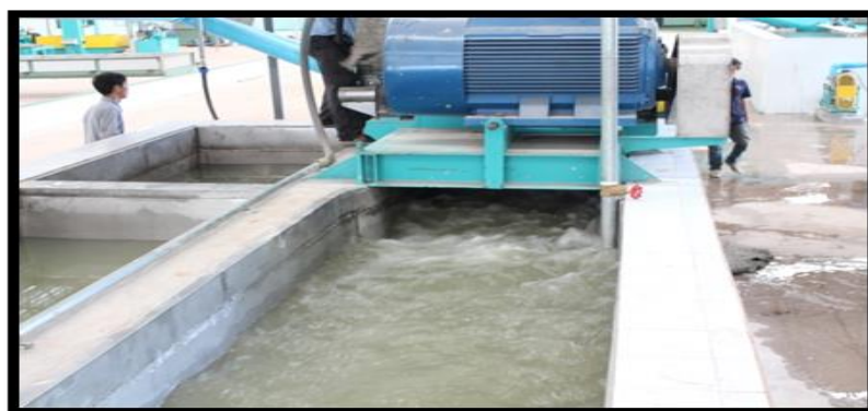
ภาพที่ 18 น้ำเสียไหลลงสู่รางน้ำรองรับน้ำเสียที่ปล่อยจากการผลิตยางมาตรฐาน 20 ที่มา: จากการสังเกตแบบมีส่วนร่วม
